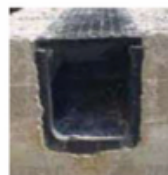
Ejemplo de hormigonado.
