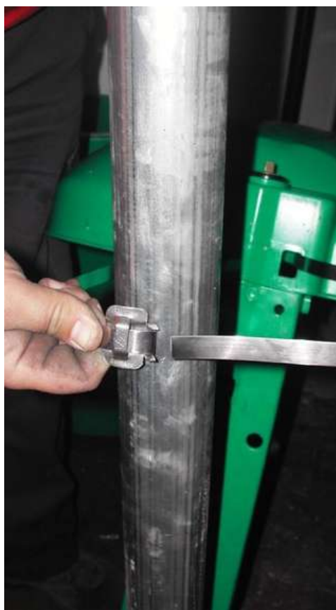
11. Pasar el otro extremo de la correa a través de la abrazadera
