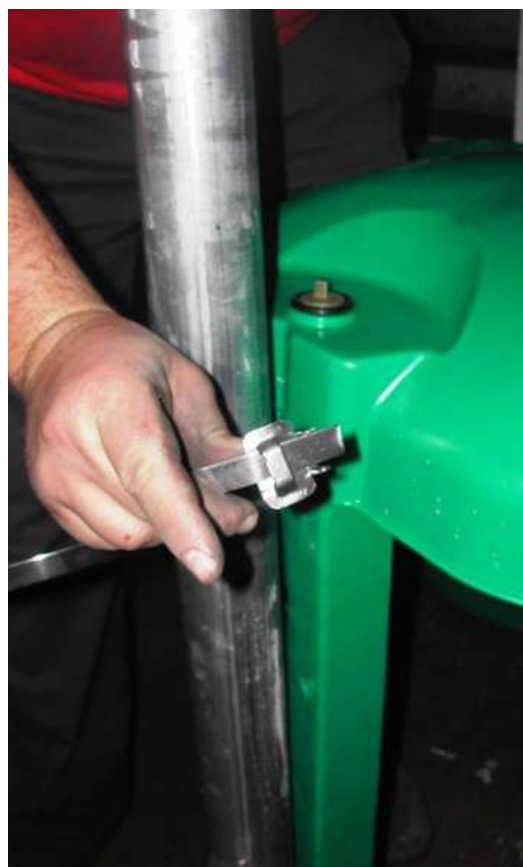
10. Colocar la abrazadera de acero inox. en un extremo de la correa y doblar la punta
