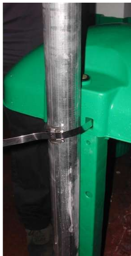
12. Apretar con fleje, cortar el sobrante, repetir la operación para colocar la correa en la parte inferior
